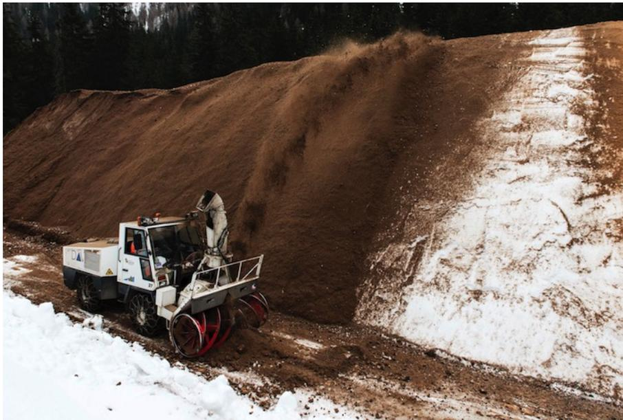
Beim «Snowfarming» wird Kunstschnee angehäuft und anschliessend mit feuchtem Sägemehl (oder anderen isolierenden Materialien) bedeckt.
